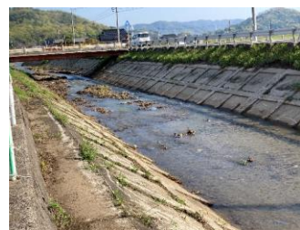
小学校前のしゅんせつ後の様子（4月時点）
