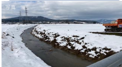
久末地内で進む河床掘削工事
