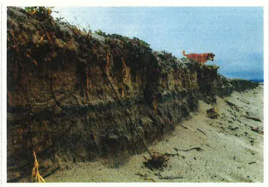
6区付近の浸食状況 (2021.5.18)
