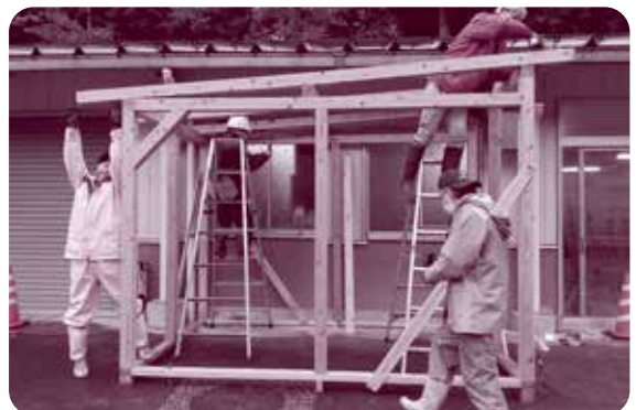
資源回収ボックス組立て中
