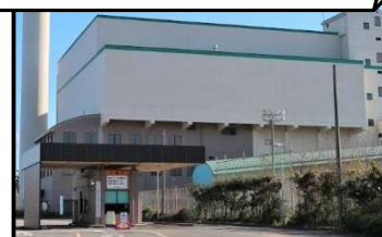
米子市クリーンセンター
