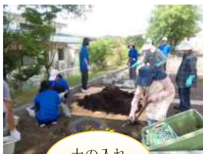
土の入れ 替え作業
