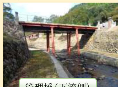
管理橋(下流側)
