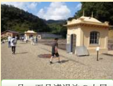
一号～五号濾過池の上屋
