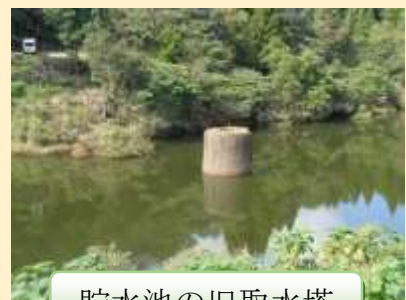
貯水池の旧取水塔
