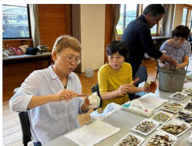
タイルが隠れないように モルタルで隙間を埋めていきます。
