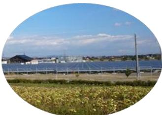
ヘクターの広大な敷地に太陽光パネル約十七万九千枚が設置され、一般家庭一万二千世帯分の使用電力量に相当する発電を行う国内最大級のメガソーラー施設です。
