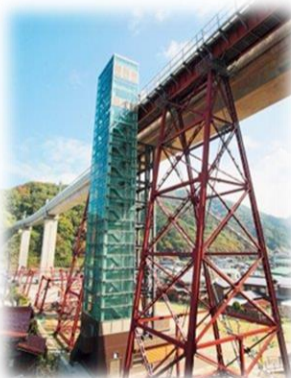
余部クリスタルタワー
