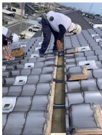
太陽光パネル取付前の下準備
