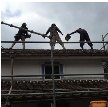
屋根葺き瓦リレー
