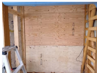
耐震改修工事
